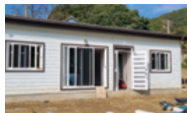
박성고 님 자택 창호 개 · 보수 후
