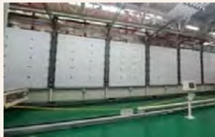
隔热材料第二工厂扩建项目
